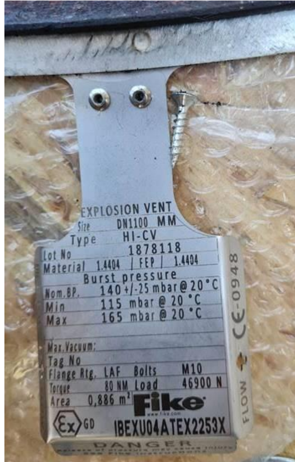
Figure 4 : Plaque signalétique de l'évent du four F10
